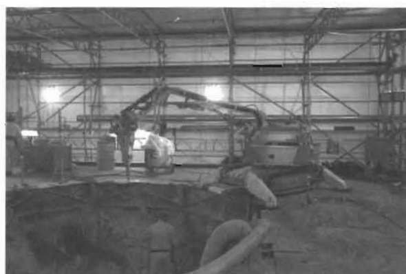
図4 ショベルローダーによる解体
