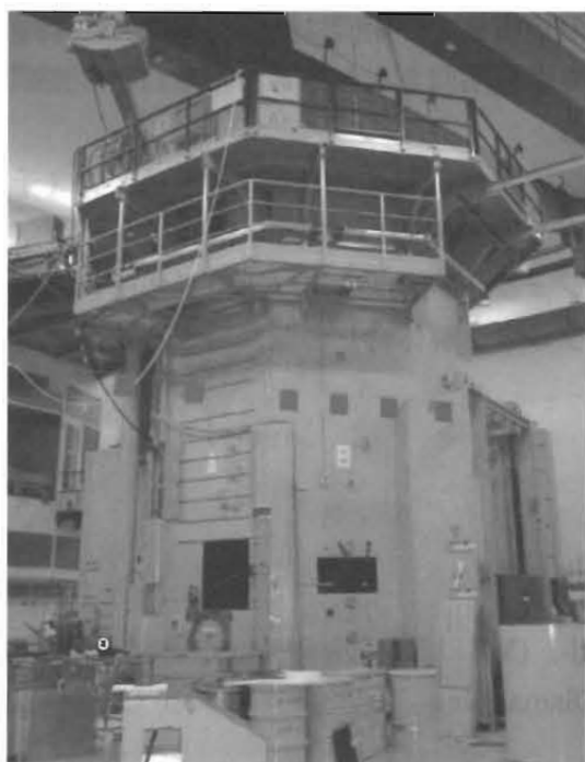
図3 解体前の原子炉ブロック
