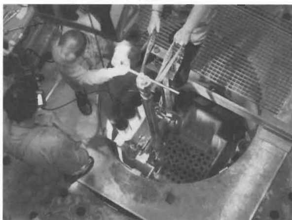
図1 原子炉タンク内のねじ緩め作業
