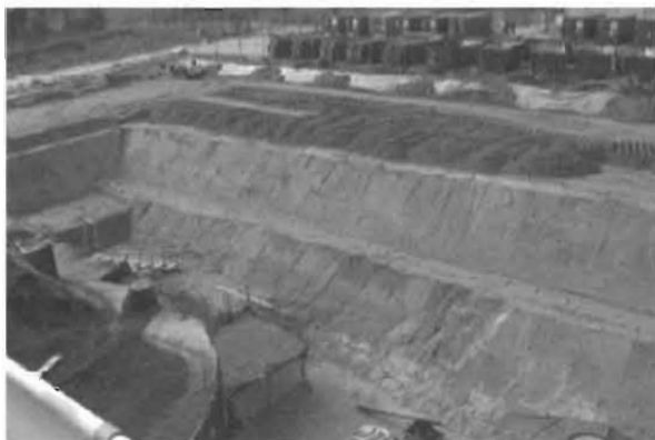
写真2-2 ALfR-Solid地下構造物撤去後の掘削跡
